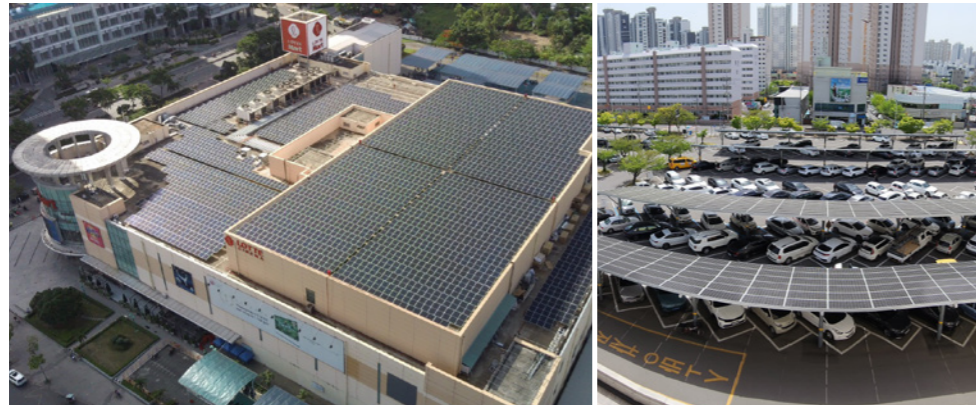
롯데마트 태양광 설비
