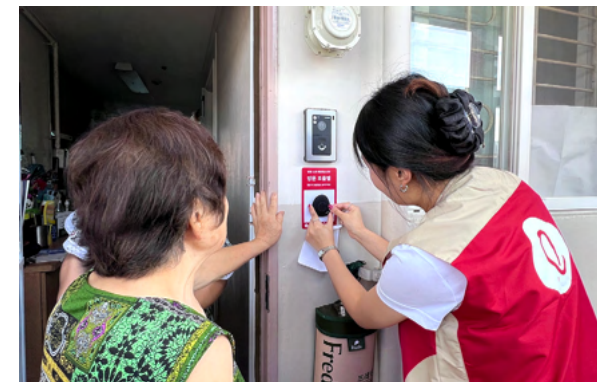
무선 초인등 설치
