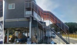
사무실, 휴게실 진입로 개선 : 전도사고 예방
