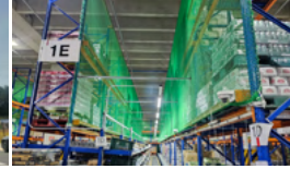
작업장 조도 개선 : 근무환경 개선
