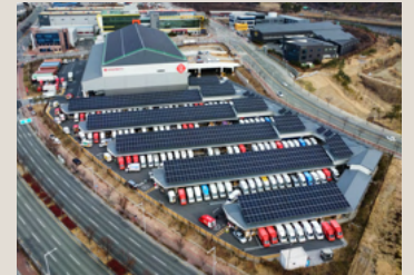
동대구Sub터미널 태양광 발전 인프라
