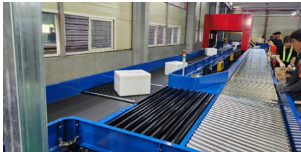
휠소터 설치 현장
