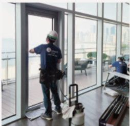
시그니엘부산 건물 단열필름 설치
