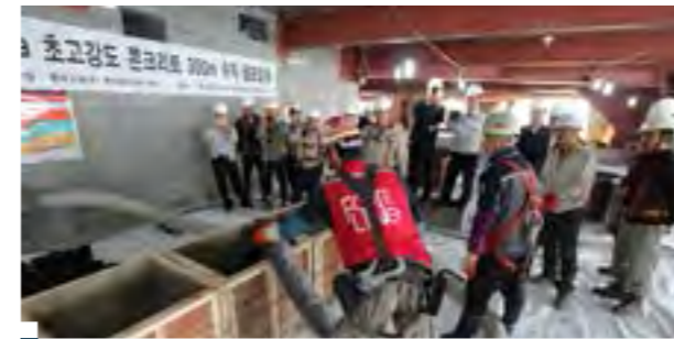
국내최초 150MPa* 초고강도 콘크리트 수직 압송 성공현장 *메가파스칼, 단위면적1cm당 1.5 Ton의 하중을 지지 할 수 있는 강도
