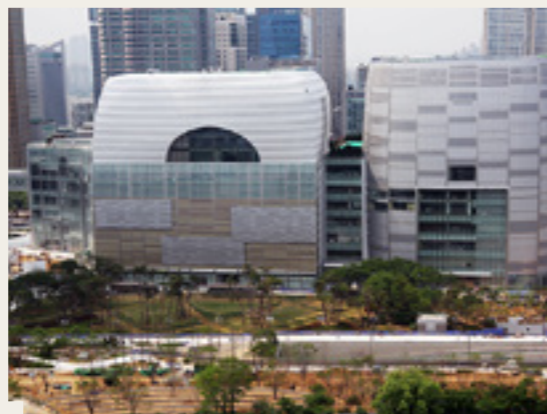
각종 친환경 및 신재생 에너지시스템이 적용된 롯데월드몰 전경
