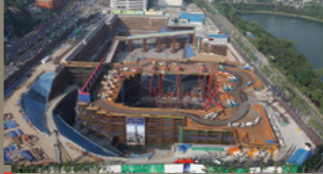
MAT 기초 타설 전경
