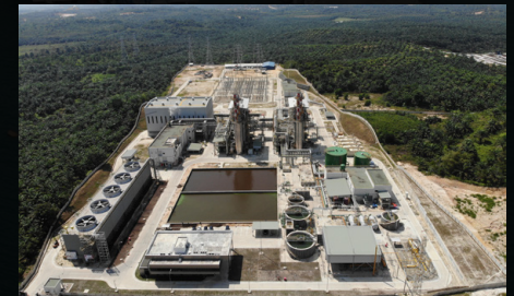
인니 Riau GFPP Project
