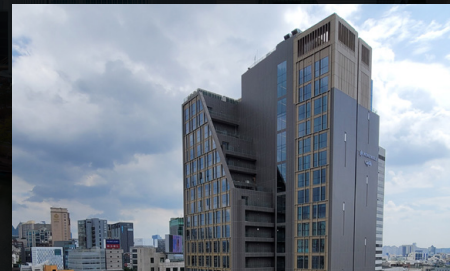
논현동 2차 복합시설 공사(펜트힐 캐스케이드)
