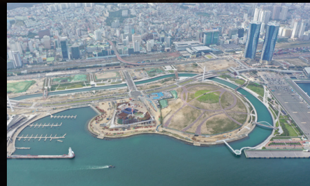
부산항(북항) 재개발사업 연결교량(1단계) 건설공사
