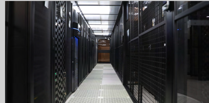
컨테이너 시스템 냉복도 전경
