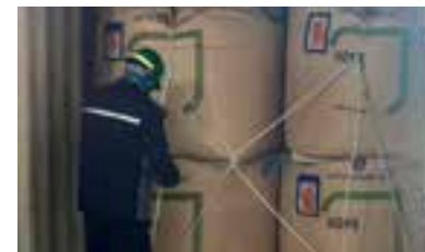
컨테이너 적입(Stuffing) 시 고박(Lashing) 개선
