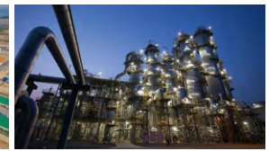
첨단소재 전남 여주시 여수산단로 334-27 주요 생산품 ABS, SAN, EPS, PC, 엔지니어드스톤, 인조대리석
