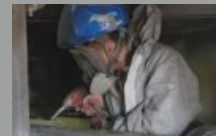
공장 복구 작업
