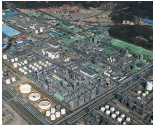
여수 에틸렌 공장 증설
