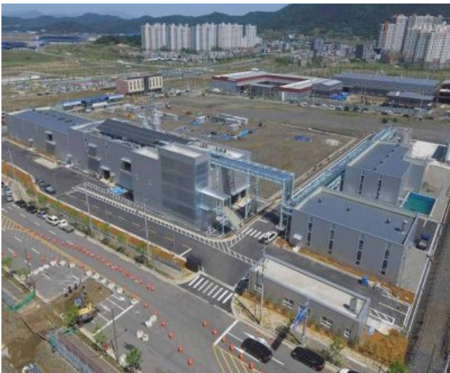
대구 수처리용 멤브레인 공장 건설
