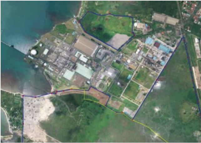
인도네시아 석유화학단지 부지조성공사
