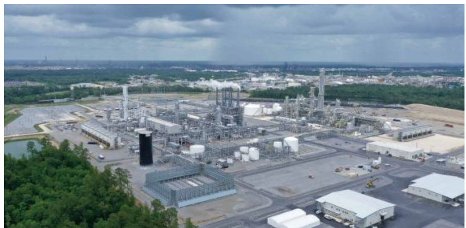
미국 루이지애나주 에탄크래커 및 에틸렌글리콜 공장 건설
