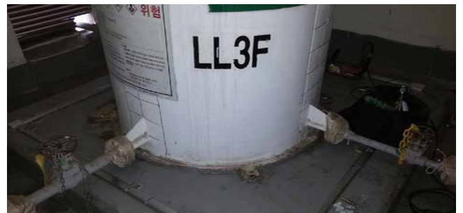
대산공장 황산 Tank 누출 감지기 설치
