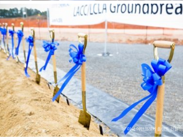
미국 에탄크래커 플랜트 건설
