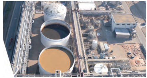
폐수처리장 이송시설 설치
