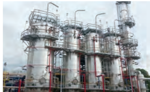
말레이시아 롯데케미칼 타이탄 TBA 공장
