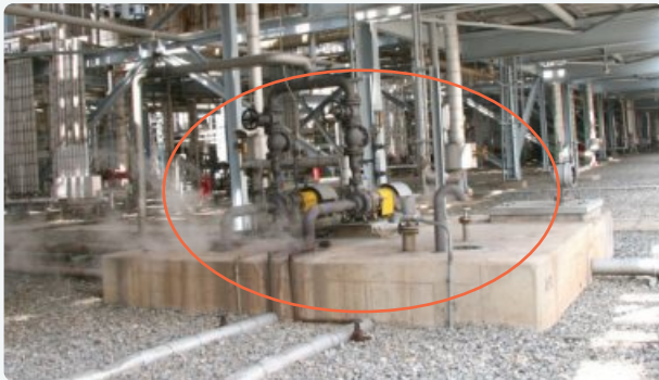
납사 분해공장 열분해로 스팀드럼 Blow Down수 재활용 - Blow Down수 냉각수로 재활용 (2002년 4월, 240 T/D)
